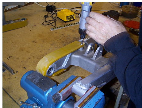
Bild 5. Montering av slitskydd.
